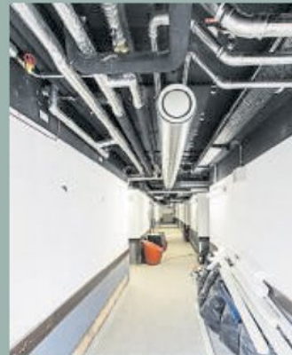
Großprojekt: das Hotel Cologne
